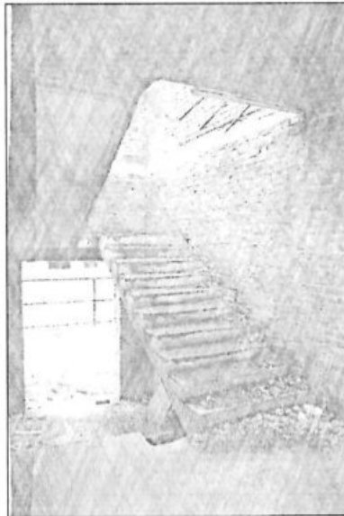
Общий вид лестничной клетки блок-секции №2 по ул. Очаковская, 2
